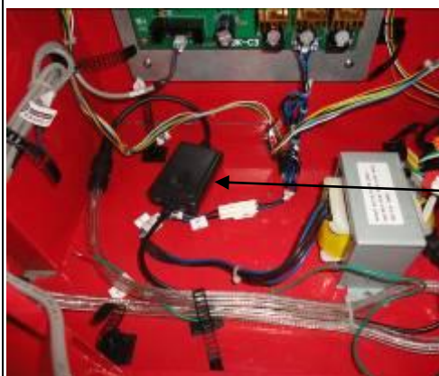
ロープラインと調整器との接続完成図
