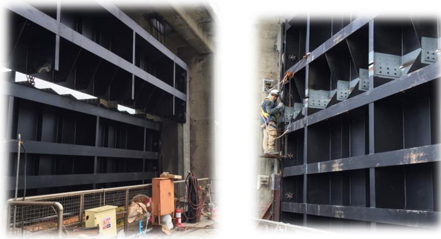
閘門分片以高張力螺栓工地接合
