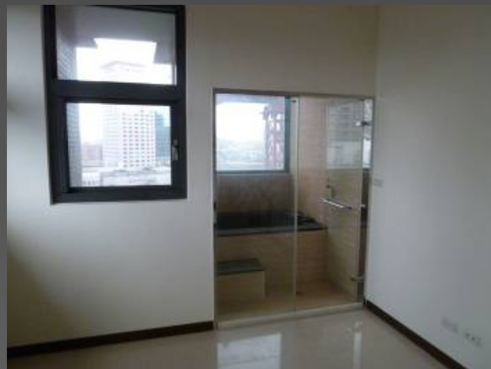
主臥浴室 移除改建
