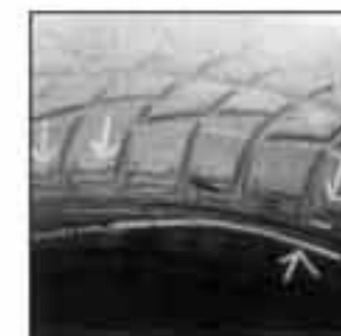
2. 擦傷:緣石等損傷。
